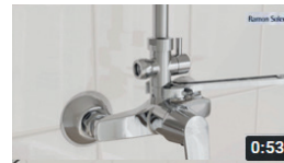
Instalacion de columnas de ducha...
